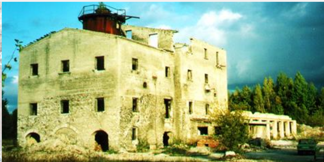
Sügis 2002 - Tamsalu lubjatööstuse šahtahjude varemed
